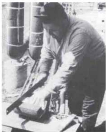
Рис. 9. Необходимые элементы изоляции FOAMGLAS® легко разрезать на необходимые размеры непосредственно на месте, используя ручные инструменты (фото с сайта [www.pcfoamglas.com](http://www.pcfoamglas.com))
