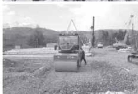
**Рис. 14. Использование пеностекла в дорожном строительстве. Фото с сайта Schaumglas—Schotter**
