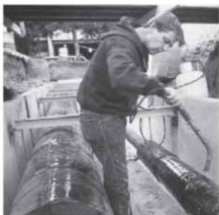
Рис. 10. Нанесение покрытия из битума на поверхность теплоизоляции из пеностекла (фото с сайта [www.pcfoamglas.com](http://www.pcfoamglas.com))
