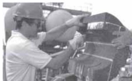
Рис. 11. Использование пеностекла специалистами компании ACS Industries Inc. для теплоизоляции продуктопровода (фото из рекламных материалов ACS Industries Inc.)
