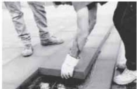
Рис. 8. Монтаж пеностекла при теплоизоляции крыши (фото с сайта [www.pcfoamglas.com](http://www.pcfoamglas.com))
